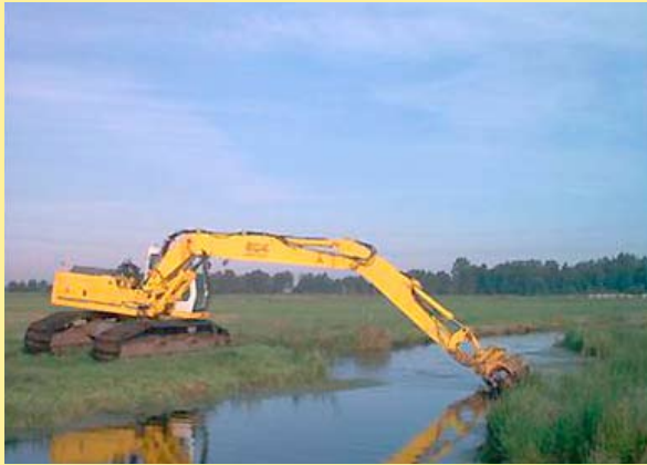
Bagger bei der Grabenräumung (Brem. Deichverband)
