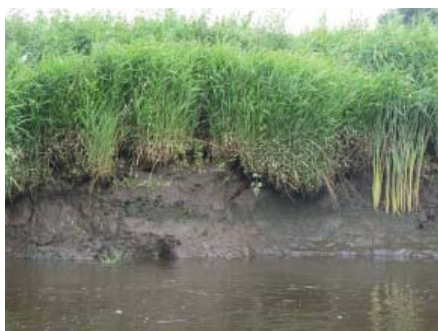
Weserausbau schädigt naturnahe Wümme: Uferabbruch an der Blocklander Wümme Foto: Gunnar Oertel
